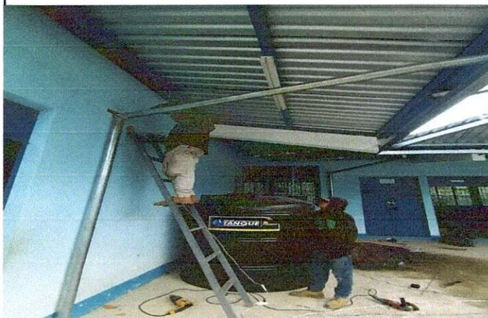
Foto 3: Instalación de bajadas de agua pluvial con tubería de metal, de los módulos, dirección, bodega y baños.
