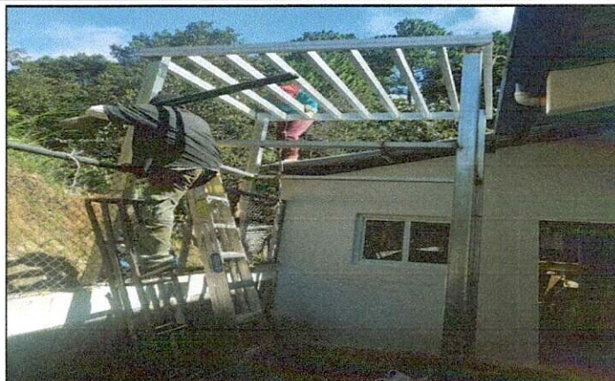
Foto 2: Instalación de torre de metal para el tinaco, tubería para el agua y accesorios.
