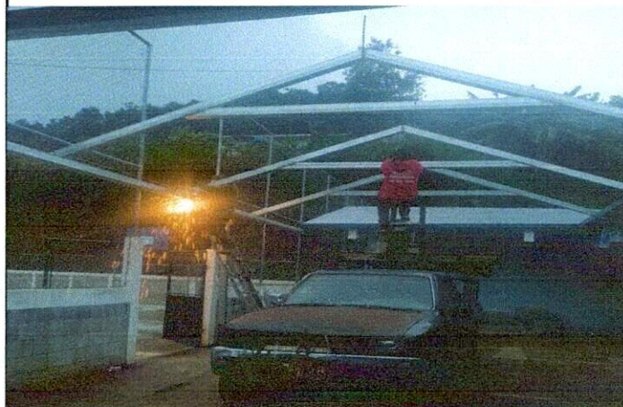
Foto 4: Instalación de techo con estructura de metal tipo pórtico con cubierta de lámina troquelada calibre 26, para el patio.
